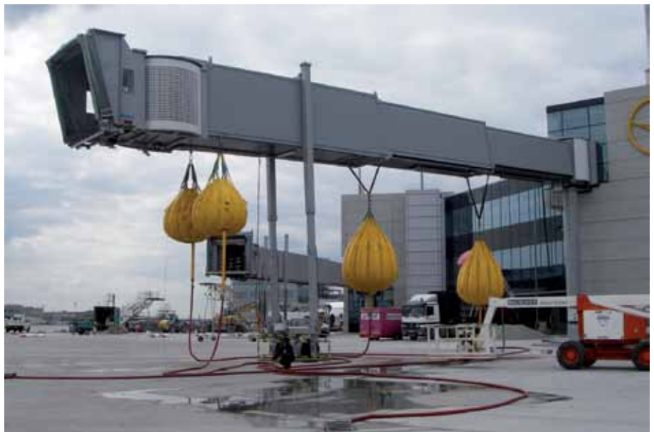
En provlastning av passagerarbrygga, avsedd för övre våningen på Airbus A380, i Frankfurt. Säckarna fylls med vatten.
