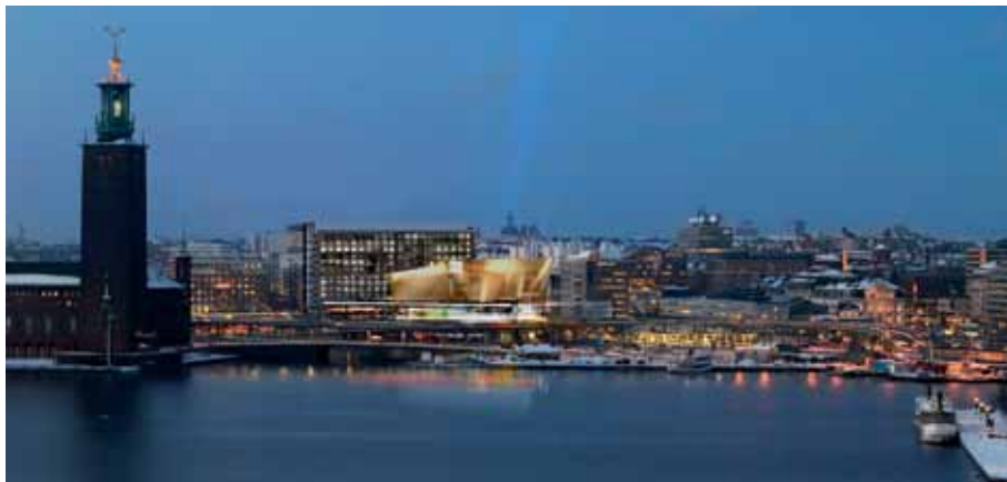
Hotellet i Stockholm Waterfront (till höger om Stadshuset) har planerats med hjälp av Vico Control. Nu har Peab gått vidare och använder Vico Office 5D för kalkylering och mängdavgivning i stora projekt. Bild: White Arkitekter AB / Jarl Asset Management AB
