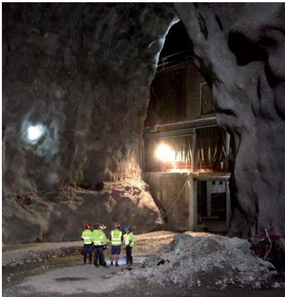
Den så kallade "Kyrkan" är in och utfarten till berg-rum 5 i Bergrumsgaraget. Bilden är tagen i "Kyrkan" efter bergsförstärkningen. Foto: Johan Ax Riise, JM AB
